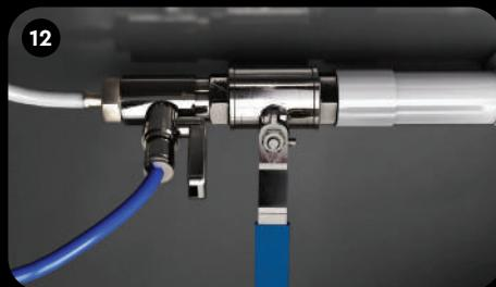
12 Открутите от крана гайку для трубы. Наденьте гайку на синюю трубку. С усилием натяните трубку на штуцер шарового вентиля до упора и закрутите гайку.
